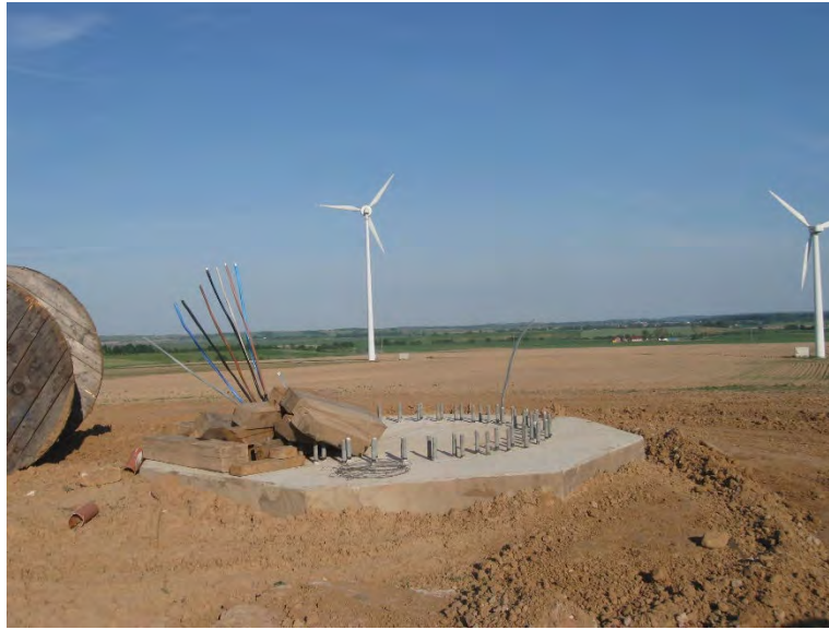
4 pav. Vėjo jėgainės pamatas, statant plieninį stiebą
